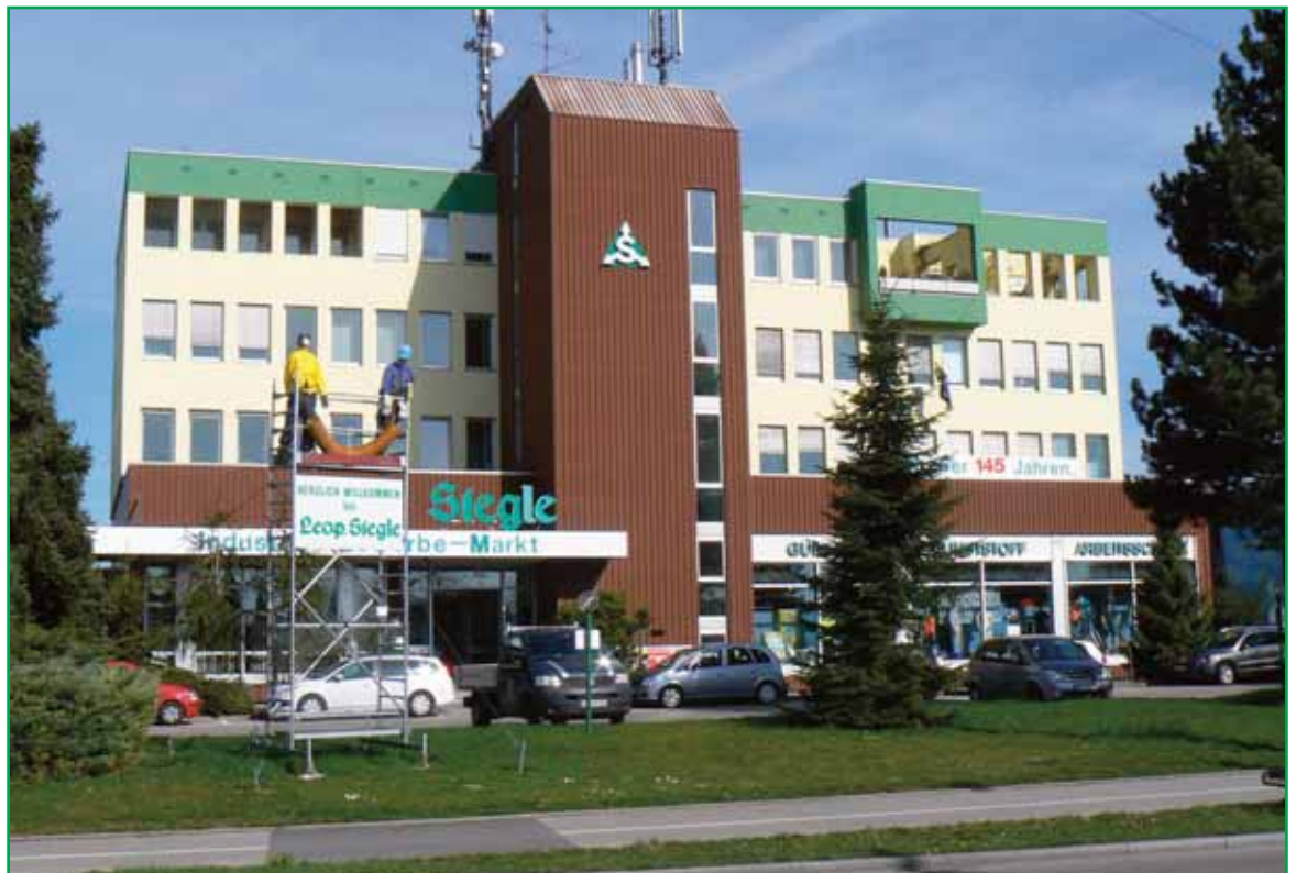
Frontansicht Verwaltungsgebäude Stammhaus Augsburg - Stätzlinger Straße 53
